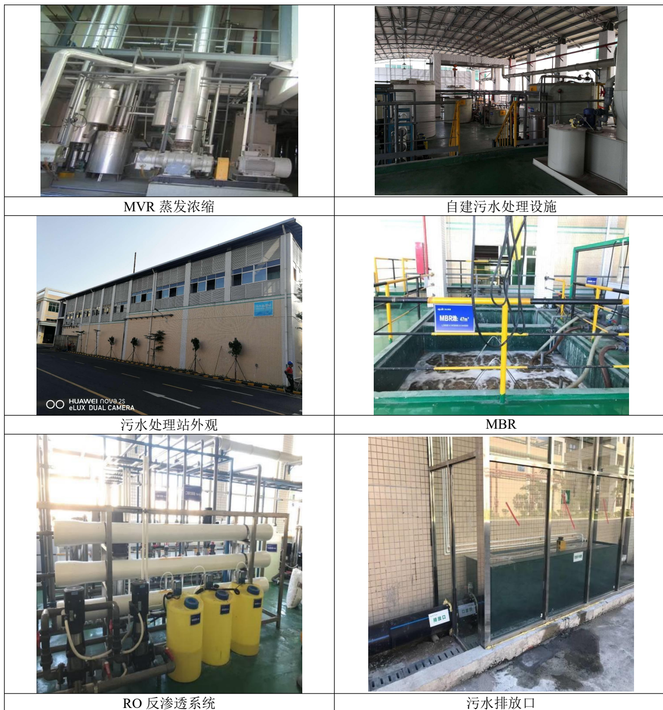
图 3.3.1-2 现有项目废水处理设施实景图
