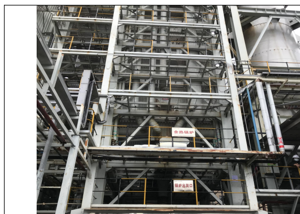
焚烧烟气余热锅炉（含 SNCR）
